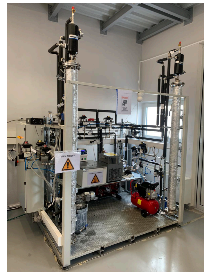
Πιλοτική μονάδα δέσμησης/απελευθέρωσης CO 2 βασισμένη σε στήλες πλήρωσης με λειτουργία αντιρροής.
