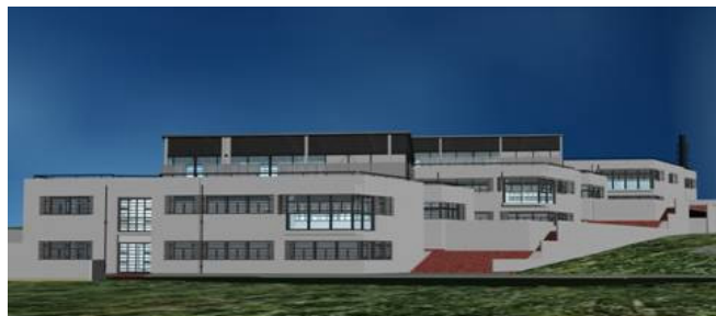
ΕΙΚΟΝΑ 5-1: Εποπτική εικόνα 1 των υπό κατασκευή κτιρίων του ΕΚΕΤΑ με το κτίριο του ΙΜΕΤ μπροστά
