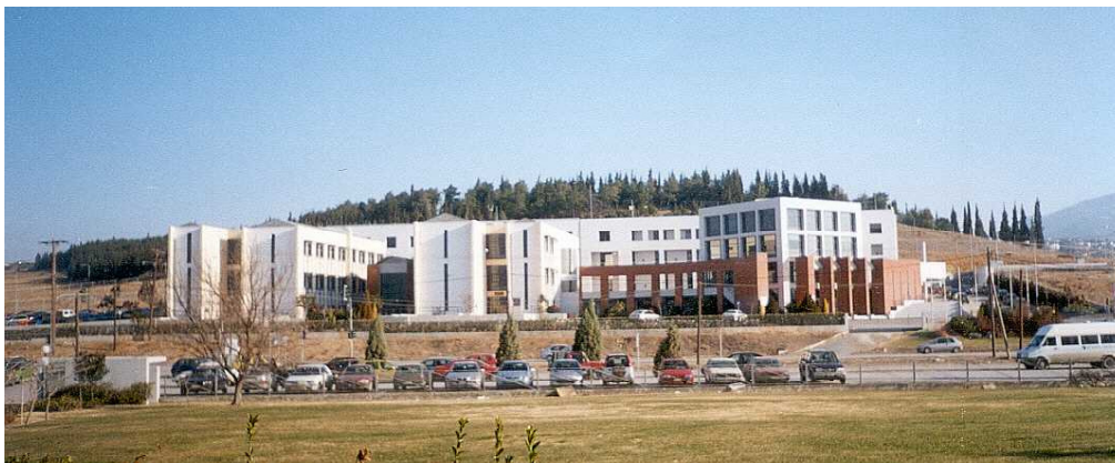
ΕΙΚΟΝΑ 3-2: Εγκαταστάσεις ΕΚΕΤΑ
