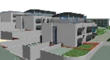
Εικόνα 5: Εποπτική εικόνα 2 των υπό κατασκευή κτιρίων του Ε.Κ.Ε.Τ.Α. (το πρώτο είναι το κτίριο του Ι.ΜΕΤ.).
