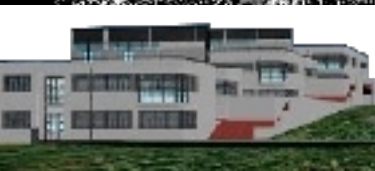
Εικόνα 4: Εποπτική εικόνα των υπό κατασκευή κτιρίων του Ε.Κ.Ε.Τ.Α. με το κτίριο του Ι.ΜΕΤ. μπροστά.
