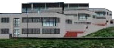
Εικόνα 4: Εποπτική εικόνα των υπό κατασκευή κτιρίων του Ε.Κ.Ε.Τ.Α. με το κτίριο του Ι.ΜΕΤ. μπροστά.
