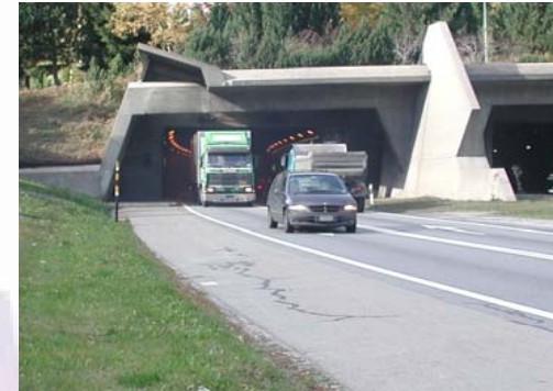
GOOD ROUTE για καθοδήγηση και ασφαλή μετακίνηση επικίνδυνων φορτίων (ADR)
